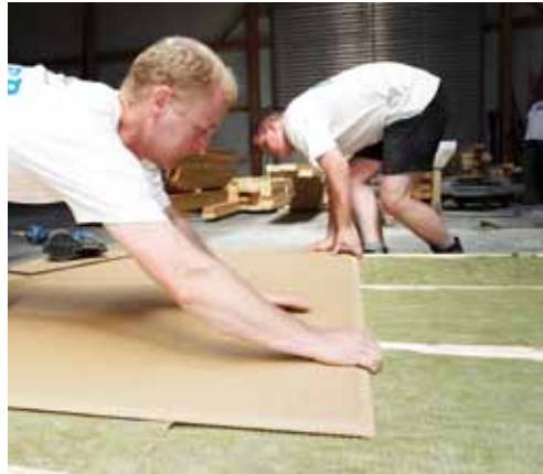
Beplankung der Außenwände.
