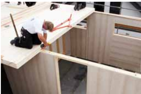
Einziehen der Zwischendecke.
