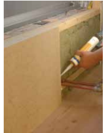
Verkleidung der Installationsebenen mit Gipsfaserplatten.
