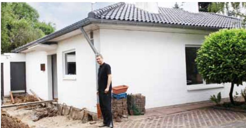
Für die geplante Wohnraumerweiterung sollte der Winkelbungalow um zwei Stockwerke aufgestockt werden.
