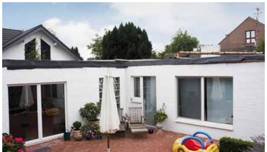
Als erstes wurde das alte Walmdach demontiert.
