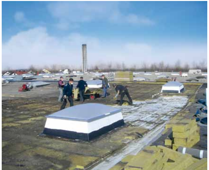
Bei guten Witterungsverhältnissen demontierten die Mitarbeiter der JNS Dachtechnik GmbH rund 1.200 m 2 Dachfläche pro Tag. Insgesamt fielen so circa 210 Tonnen Altdämmstoff zur Entsorgung an.
