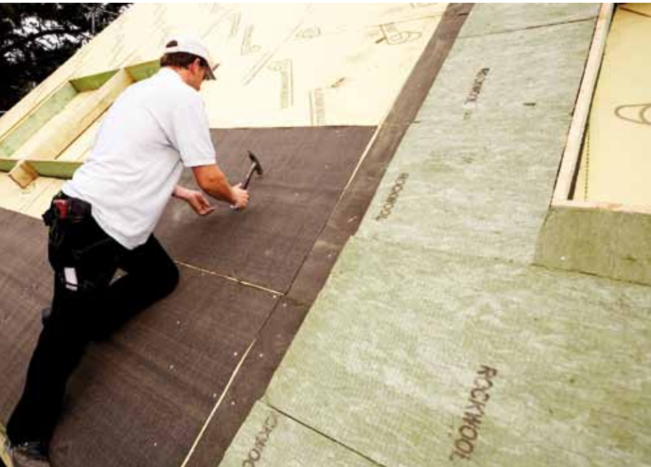
Eine zusätzliche Bitumenbahn unter der Dämmschicht sorgt für zusätzliche Dachmasse.
