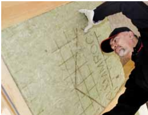
Trotz hoher Dämmdicke und schwankenden Sparrenabständen konnte die Steinwolle-Dämmung mit wenigen Handgriffen zuverlässig zwischen die Sparren geklemmt werden.
