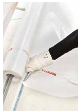
Zuschneiden der Dampfbremse „Rockfol PE“.
