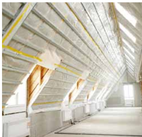
Rund 3.000 m 2 Dachfläche wurde in nur wenigen Tagen gedämmt.
