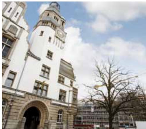
Alt neben neu: Das 1908 erbaute Rathaus in Gladbeck erhielt einen angrenzenden Erweiterungsbau mit zusätzlichen 8.000 m 2 Nutzfläche.
