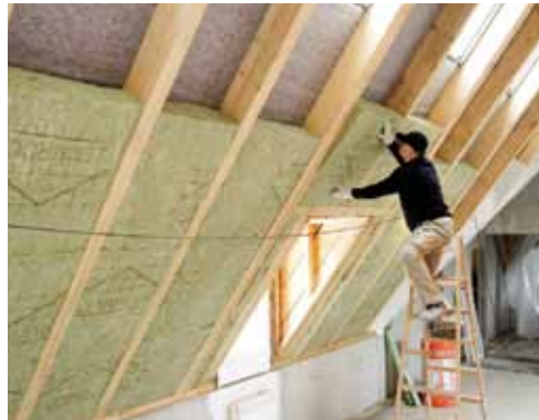
In dem mit einem hohen Wärmeschutz ausgestatteten Dachgeschoss arbeiten heute die Mitarbeiter der Hochbau- und Planungsabteilung der Stadt Gladbeck.
