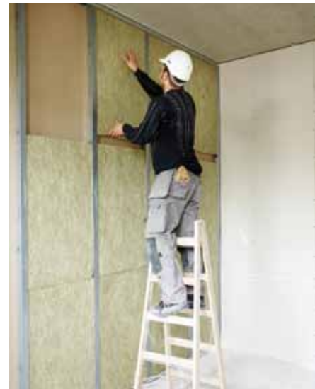
Auch die in Trockenbauweise errichteten Trennwände erhielten eine hochwertige Dämmung aus nichtbrennbaren Steinwolleplatten.
