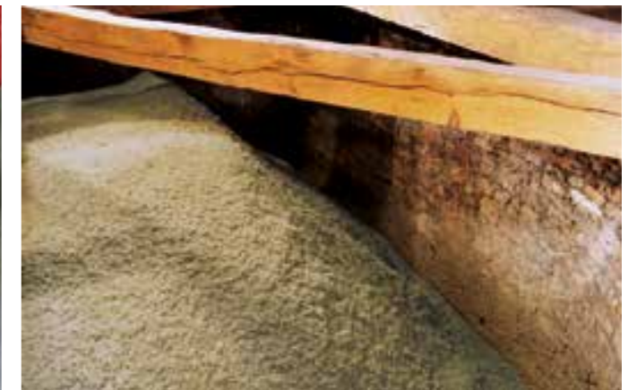
Abrutschsicher mit Fillrock RG aufgebaute Dämmschicht. Die Dämmschicht ist auch bei gewölbten Untergründen lagestabil.
