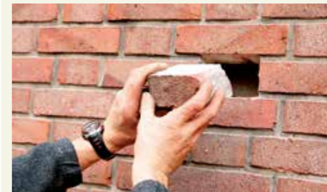
Aus dem Vormauerwerk wird ein ganzer oder ein halber Ziegel entnommen.
