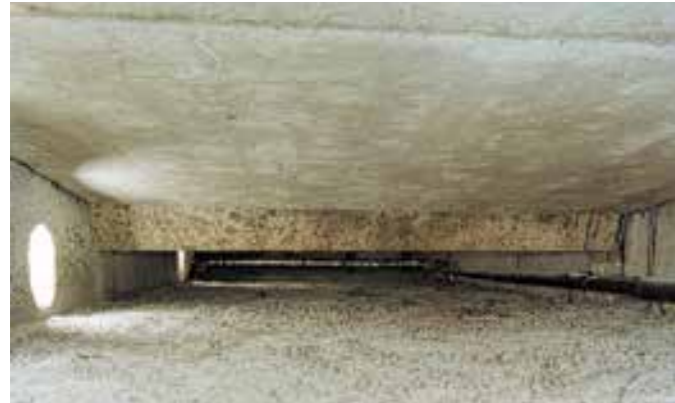
Belüftetes Flachdach vor dem Einbringen von Fillrock RG
