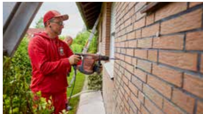
Im Anschluss erfolgen Bohrungen in die T-Fugen der Fassade in gleichmäßigen Abständen.
