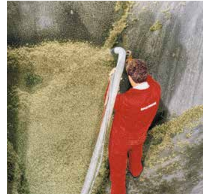
Gleichmäßiges Aufbringen der fugenlosen Dämmschicht. Anschlie-ßend werden die Steinwolle-Flocken mit Sprühkleber benetzt.
