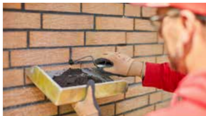
Selbstverständlich werden die Bohrlöcher nach dem Einblasvorgang wieder sauber verfugt ...
