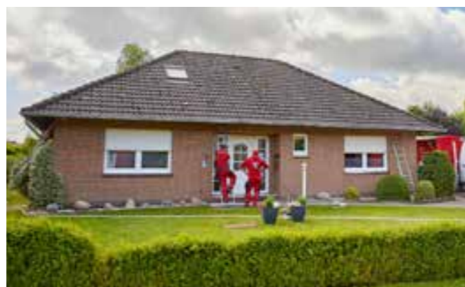
..., sodass man später nicht mehr erkennen kann, an welchen Stellen sich die Bohrlöcher befanden. Schnell, sauber und unkompliziert.
