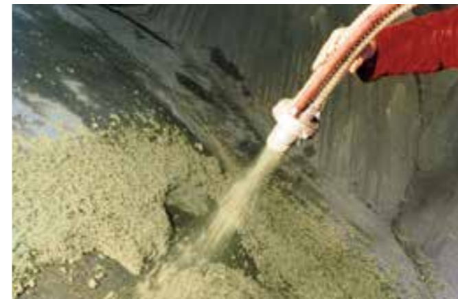
Steinwolle-Flocken und Sprühkleber werden mithilfe einer speziellen Düse aufgebracht.
