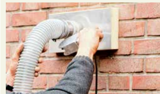
Die Großdüse wird aufgesetzt und der Hohlraum ausgeblasen.
